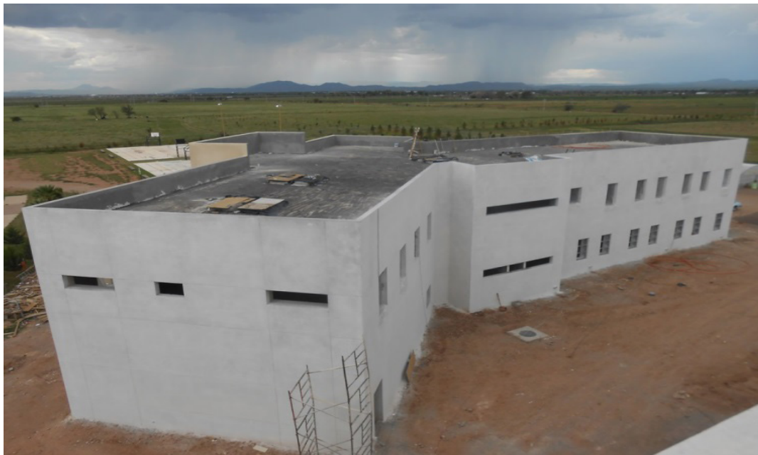
Edificio multifuncional "E" en la DMNCG.
